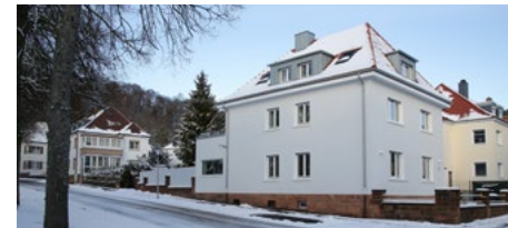
Die Außenfassade erhielt einen neuen mineralischen Filzputz und Anstrich. Die vorhandenen Sandsteinsockel und die Gewände wurden gereinigt und renoviert
